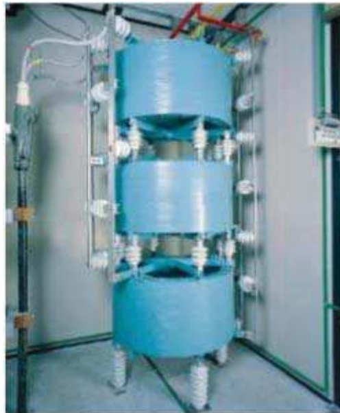
Fig. 2.9 - Arranjo trifásico com reatores sobrepostos. Fonte: catálogo (GE, 2018).
