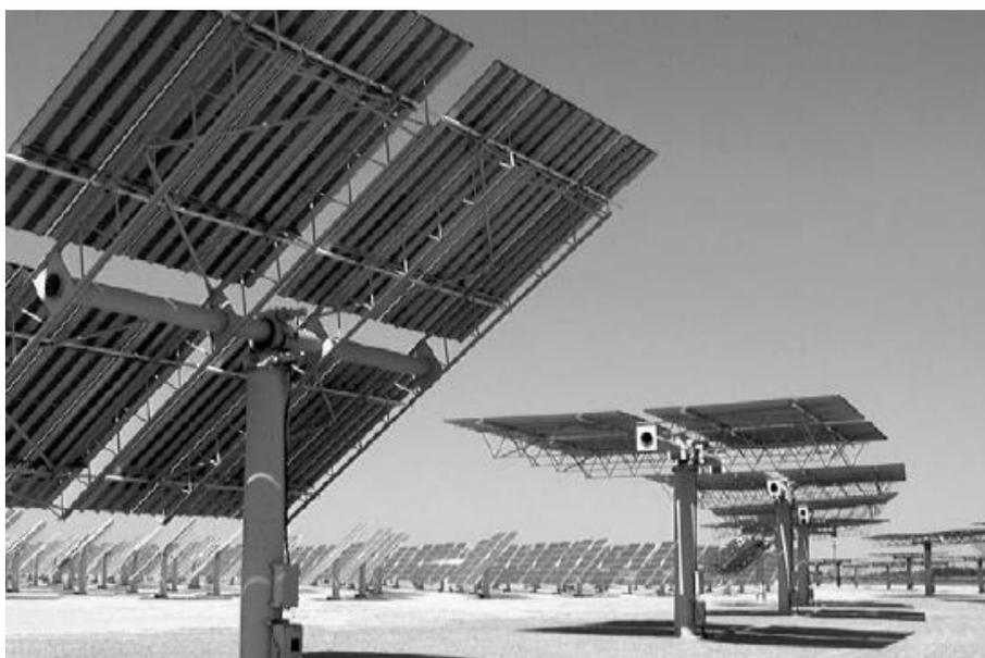
Figura 13 – Sistema de suportes com quatro espelhos refletivos instalados
