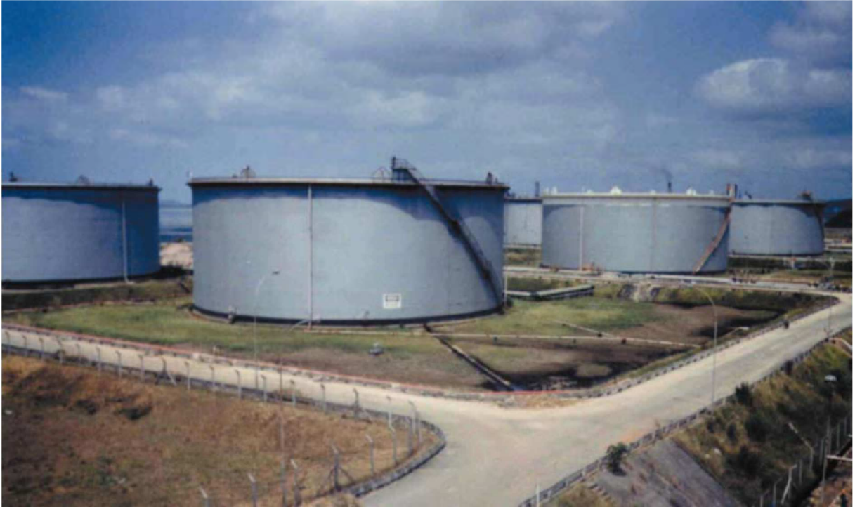
Figura 6: Tanques de armazenamento atmosféricos Fonte: Barros (2006, p.20)
