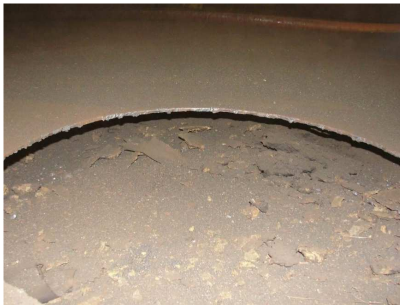
Figura 3: Ausência de contato entre chapa de fundo e solo Fonte: Elaborado pelo autor (2009)
