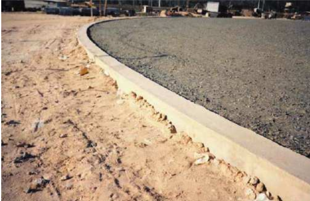
Figura 8: Fundação direta com anel de concreto Fonte: Barros (2006, p.3)
