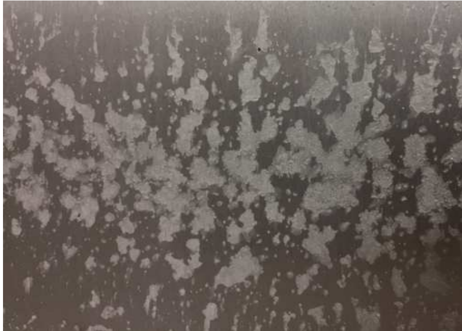
Figura 39: Área corroída da chapa Fonte: Elaborado pelo autor (2018)
